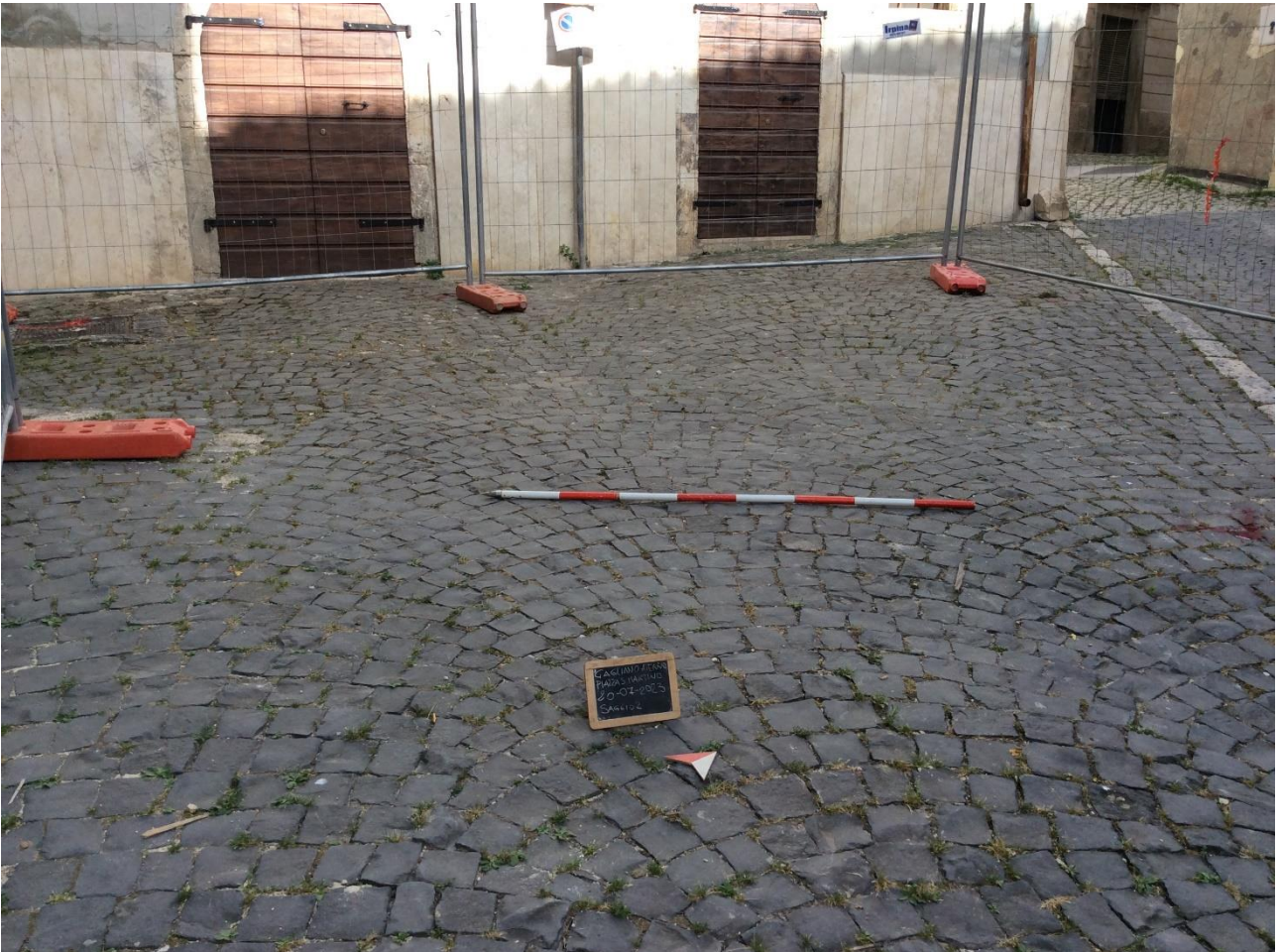
Fig. 13 Saggio 2 – Prima dell'inizio dello scavo dopo la cantierizzazione.
