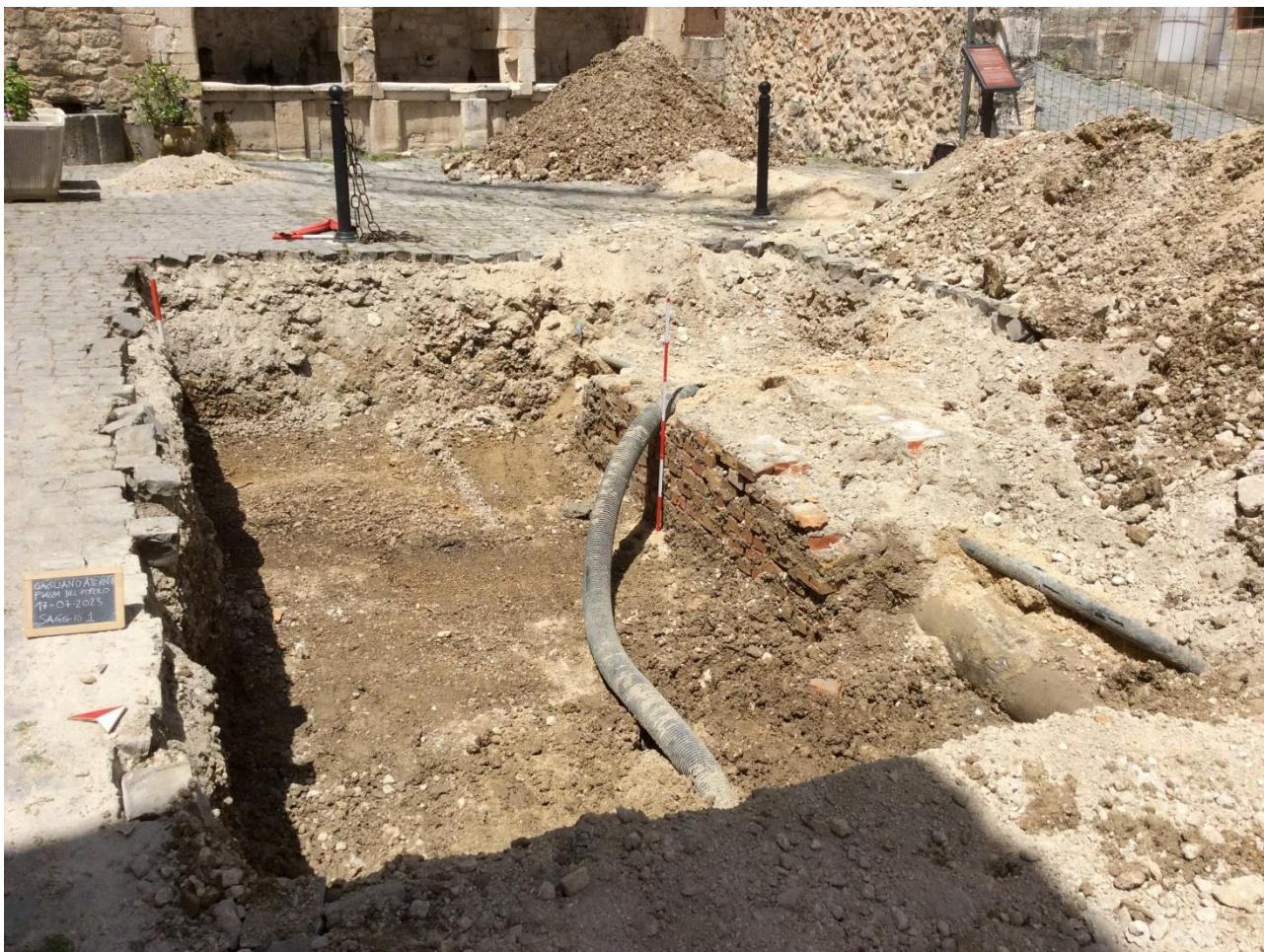
Fig. 11 Saggio 1 – Fine scavo. Si nota nella metà E la condotta in cemento e gli altri sottoservizi. Vista da S
