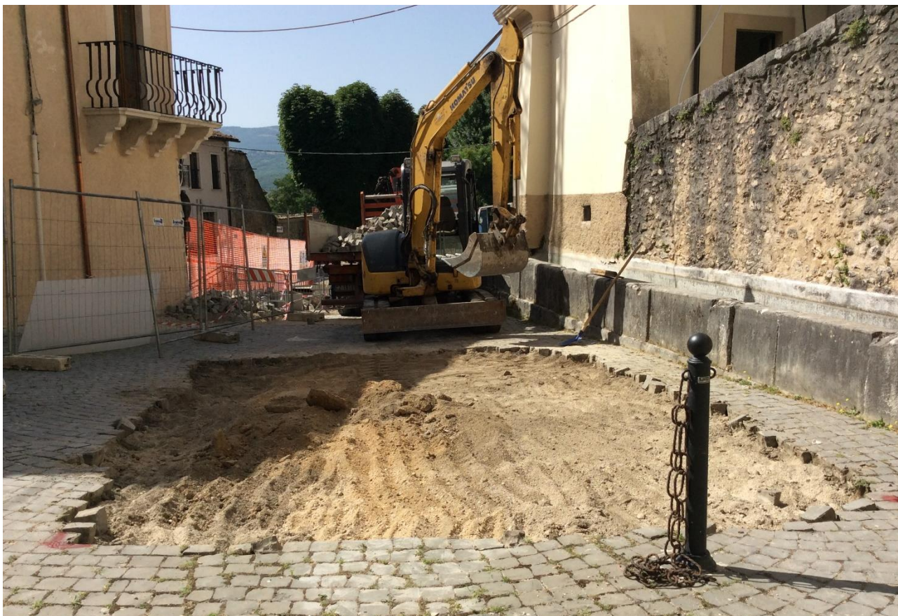
Fig. 9 Saggio rimozione sanpietrini
