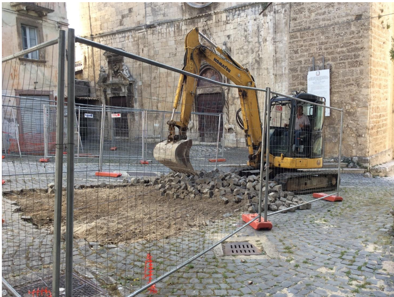
Fig. 14 Saggio 2 – Dopo la rimozione dello strato di sanpietrini
