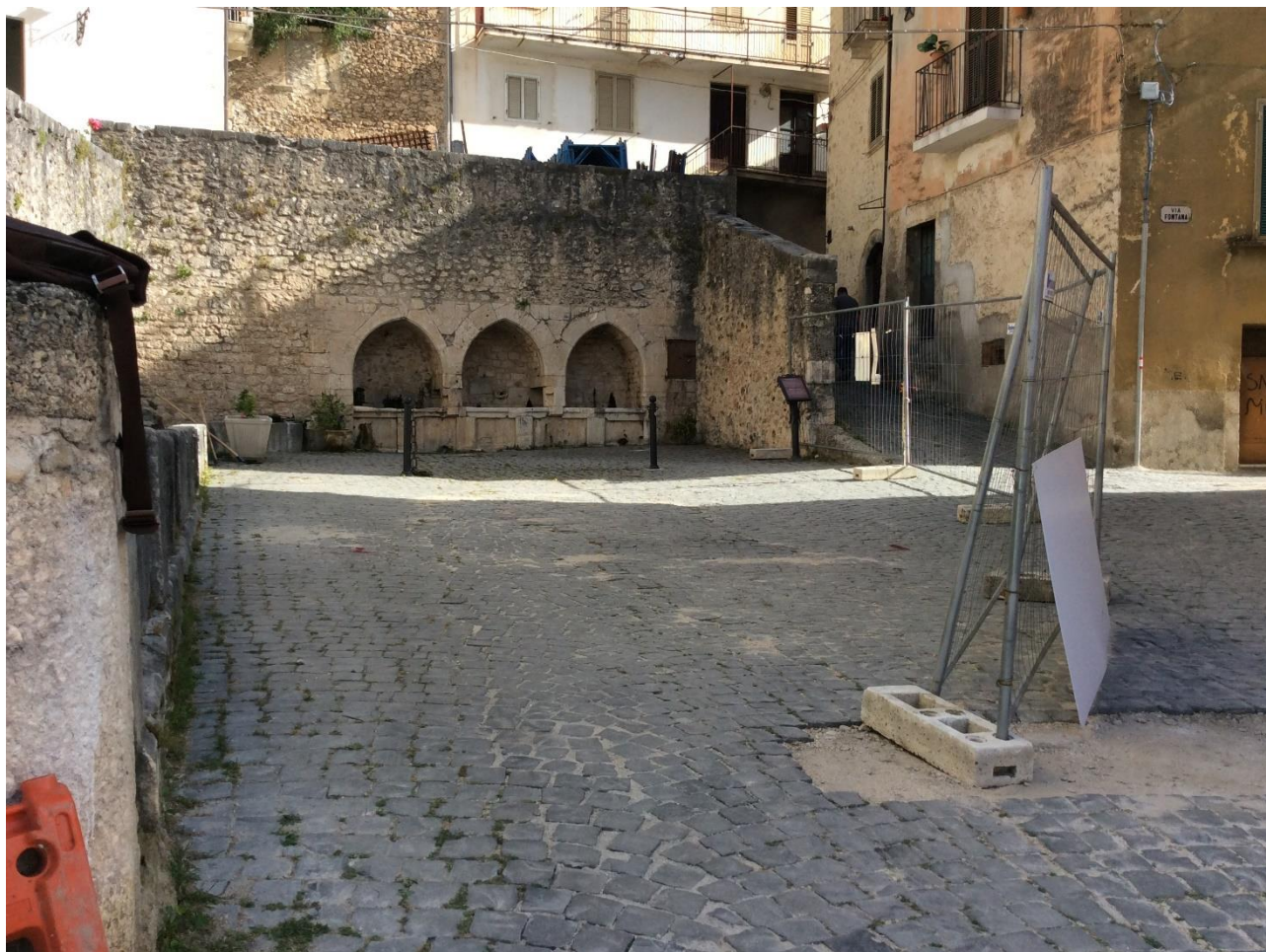
Fig. 7 Piazza del Popolo, prima dell'inizio del saggio 1, nella fase di cantierizzazione.
