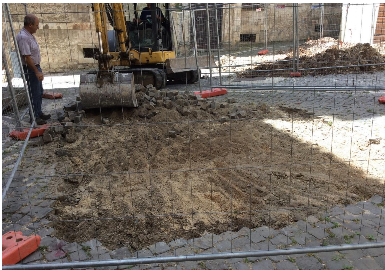
Fig. 18 Saggio 3 – Inizio scavo. Si toglie la pavimentazione.
