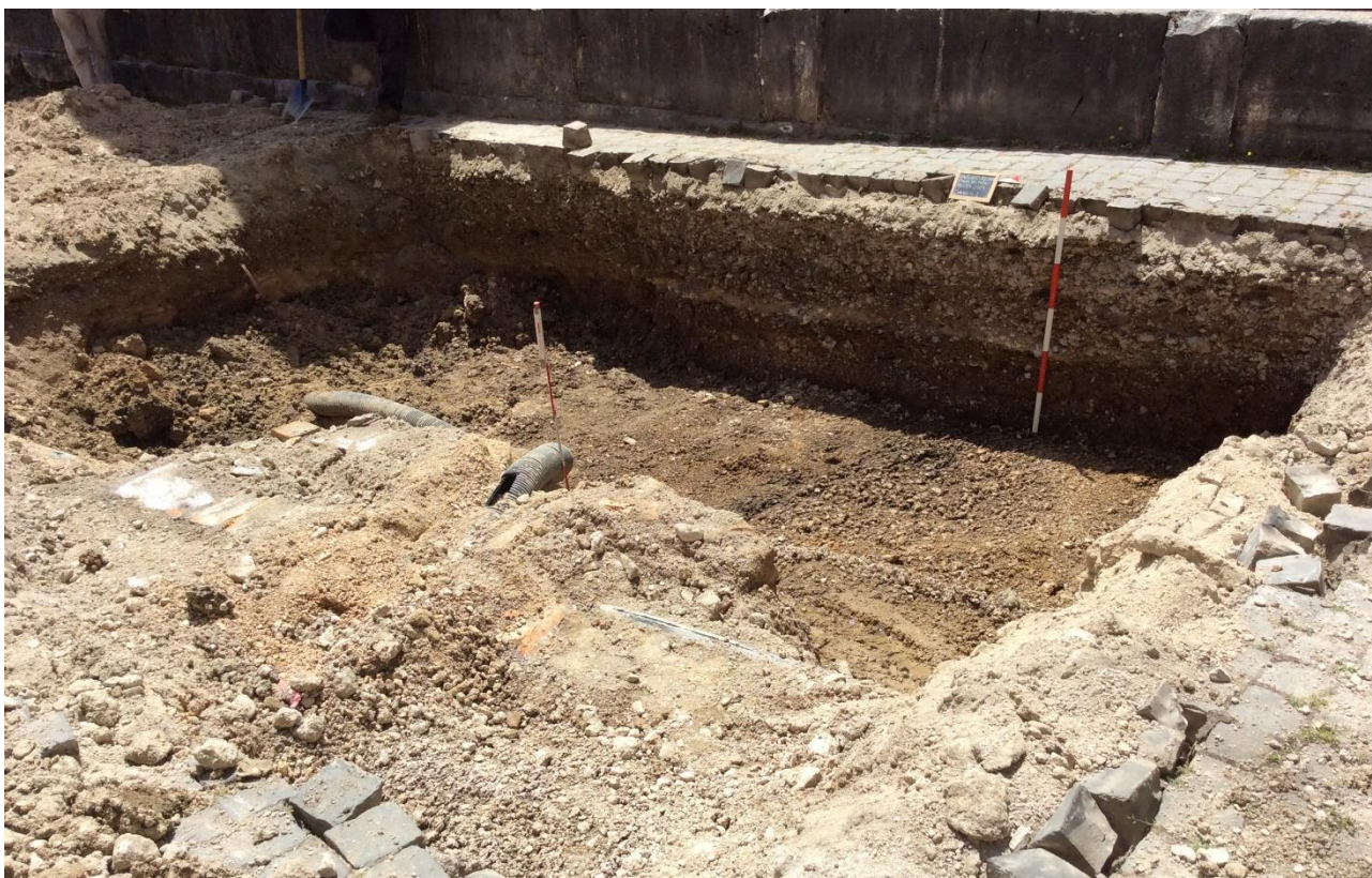
Fig. 12 Saggio 1 – Fine scavo. Vista da NE.
